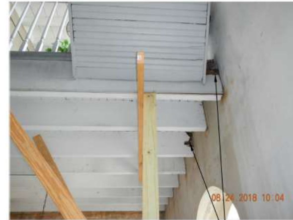
3 PHOTO SCALE: N.T.S. EXISTING
