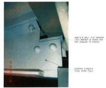
8 STEEL BEAM CLOSE UP SCALE: N.T.S. EXISTING
