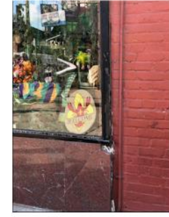
E) DUMAINE STREET [10][12][8][17] WALLS / TRIM / WIRING / CONDUIT / SIGNAGE
