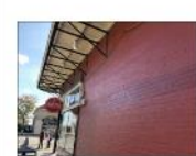
L) DUMAINE STREET [7][8] LIGHTING / WIRING / CONDUIT
