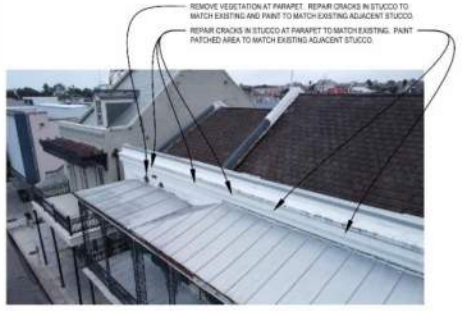
7 BUILDING #1 - RAMPART ST. ELEVATION SCALE: N.T.S.
