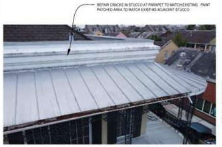
4 BUILDING #1 - RAMPART ST. ELEVATION SCALE: N.T.S.
