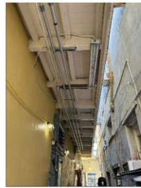
9 new electrical conduits
