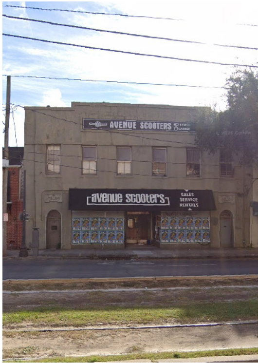
1. Site | 1132 St. Charles Ave
