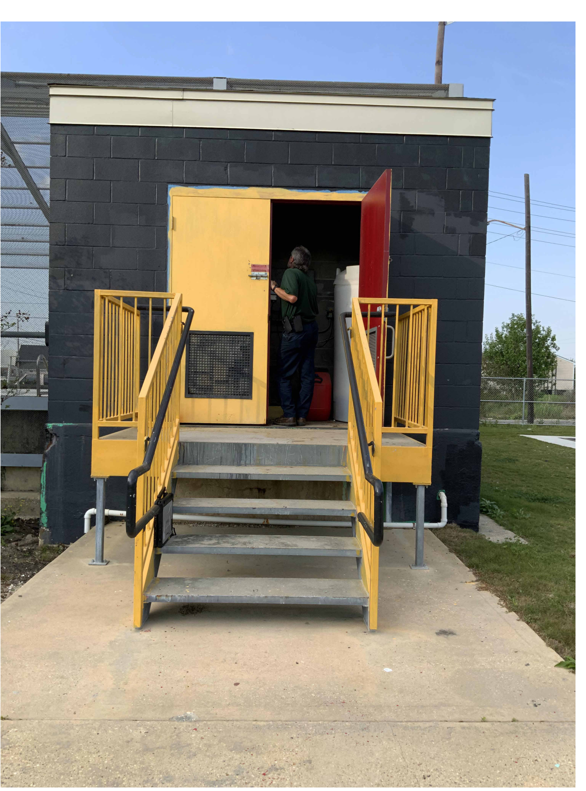
EXISTING PHOTO 3 12" = 1'-0" A3
