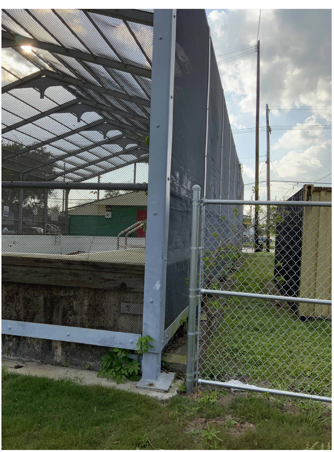
EXISTING PHOTO 4 12" = 1'-0" A4
