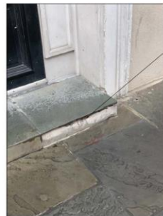
2 SLATE REPAIR A1.00 N.T.S.
