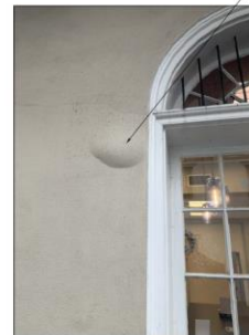
4 WATER DAMAGE A1.00 N.T.S.
