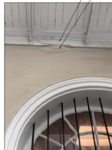
3 WATER DAMAGE A1.00 N.T.S.
