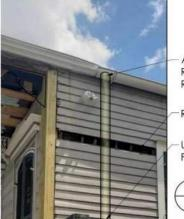
ADD A 4" ROUND GALVANIZED HALF ROUND B STYLE OUTLET FOR NEW 4" ROUND DOWNSPOUT TO MATCH OTHERS
